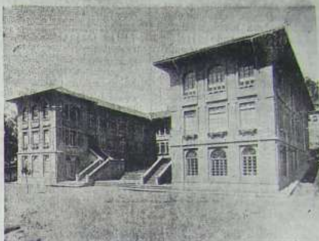
Edificio del Instituto Normal "Juan Montalvo" Quito—Ecuador
